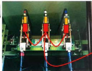
キュービクル内に取付けた短絡接地器
