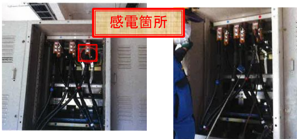
手鏡による盤内確認実施時に感電
