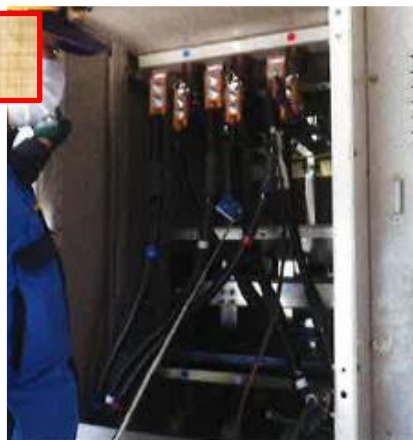
手鏡による盤内確認実施時に感電
