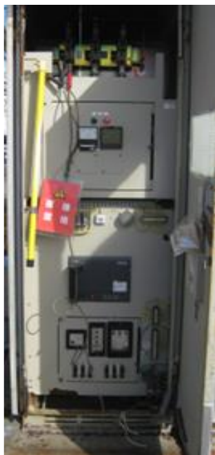
受電盤 短絡接地器具
