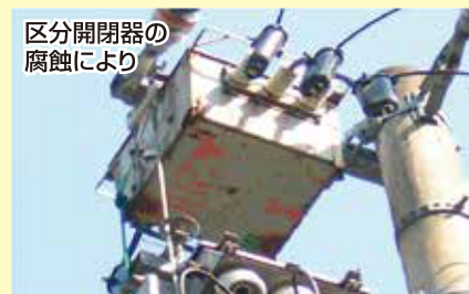
キュービクルの 腐蝕により
