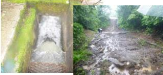
解体工事箇所(R5.7.12)
