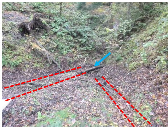
【山腹水路の埋没】
