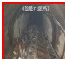
① 覆工補修(坑道上部裏側の空洞部の充填を実施)
