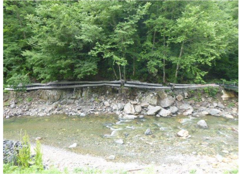
(発生後)護岸が豪雨で流され、導水管を仮復旧した際の護岸
