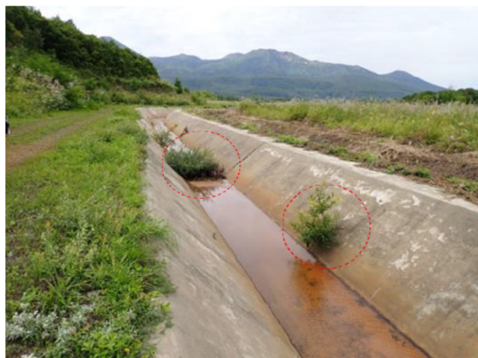
【山腹水路等の維持管理】 (水路の水抜孔に樹木育成。水路コンクリート部亀裂恐れあり)
