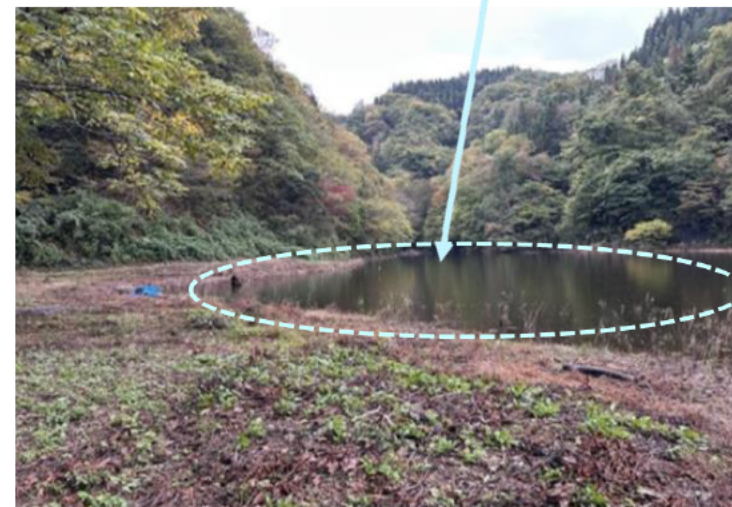
【上澄水の排除】 (豪雨により竖樋が閉塞し、湛水が発生。通水機能の回復必要)
