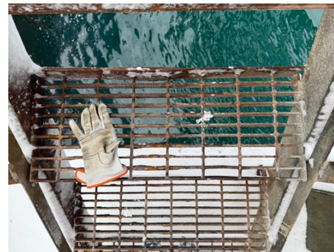
階段面の状況
