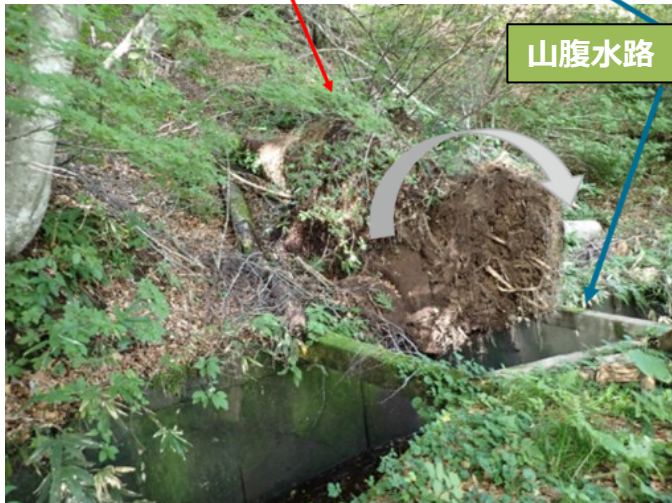
【山腹水路等の維持管理】 （倒木が放置により落下し、水路塞ぐ恐れあり）
