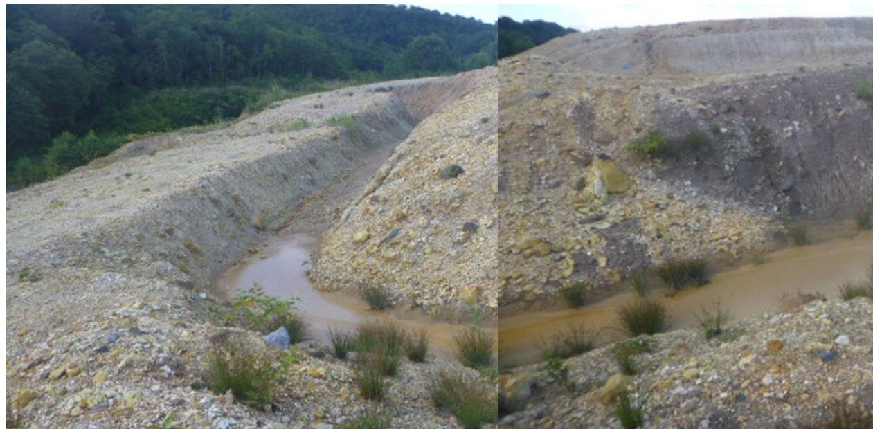
集積場 場内湛水（場内水排除）
